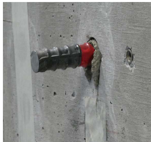
③ 鉄筋挿入
