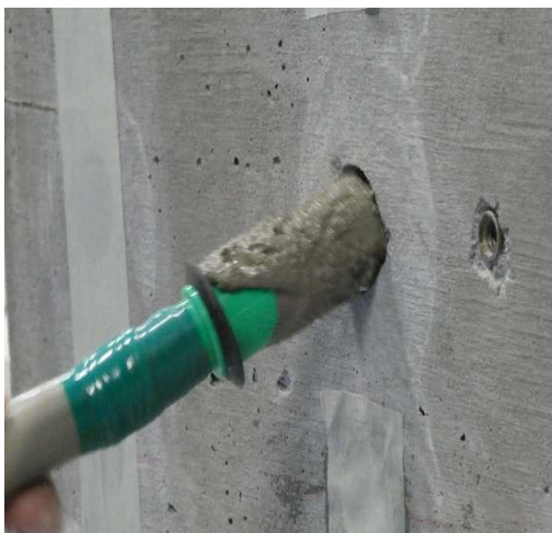
② 接着材注入
