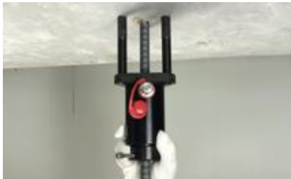
1 異形鉄筋に反力台とシリンダーを設置
