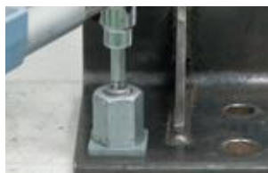
4 止めねじをセットし、ヘキサゴンヘッドのトルクレンチで規定値まで締め込んで完了。(合いマークをつけることをおすすめします。)
