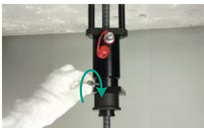
4 ポンプを接続して予荷重を掛け、 仮止めを解除
