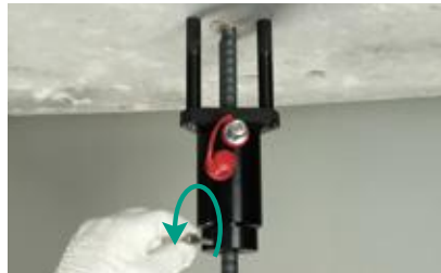
2 仮固定治具のノブを回し、仮止め
