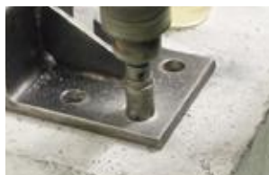
被締結体に拡大孔を設けます。▶Aタイプと同じ施工手順になります。
