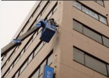
看板を取り外してから試験
