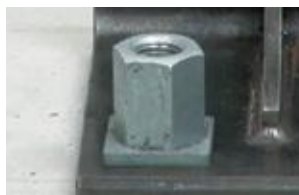
3 ロングネジナット本体をセットし、トルクレンチで規定値まで締め込みます。
