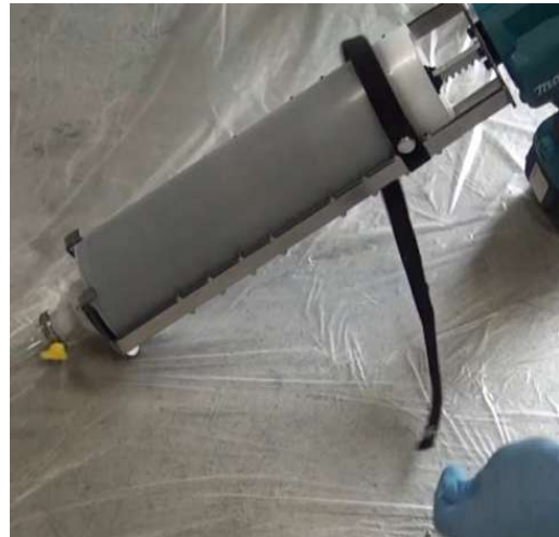
③ 電動ガンに容器を設置、バンドで容器を固定する(左:1LC 右:2LC)
