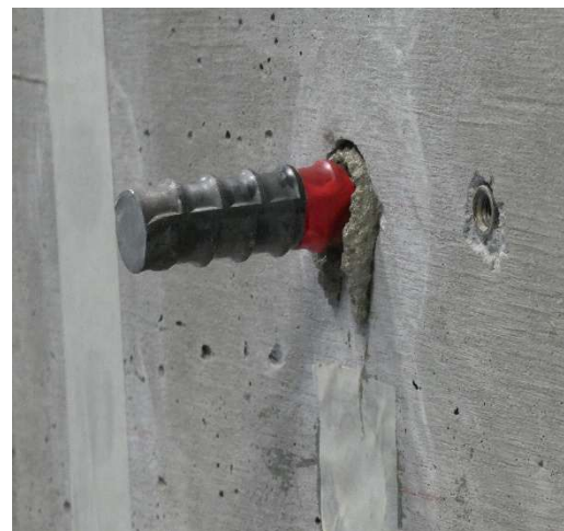
⑤ 鉄筋挿入
