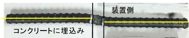
図-5 加力後のアンカー筋の変形 (90°回転して表示)
