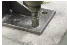
①被締結体に拡大孔を設けます。▶ Aタイプと同じ施工手順になります。
