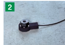
センターホール型荷重計を設置 ※凹凸面などは、水平になるように鉄板やクサビなどで調整
